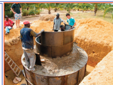
Cuve en phase de construction
